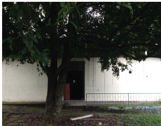
FIG. 07 LATERAL ESQ. DO PRÉDIO (REF. SEDAJ)
