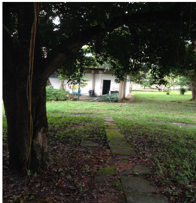
FIG.06 VISÃO DE DENTRO DO PRÉDIO A SER REFORMADO
